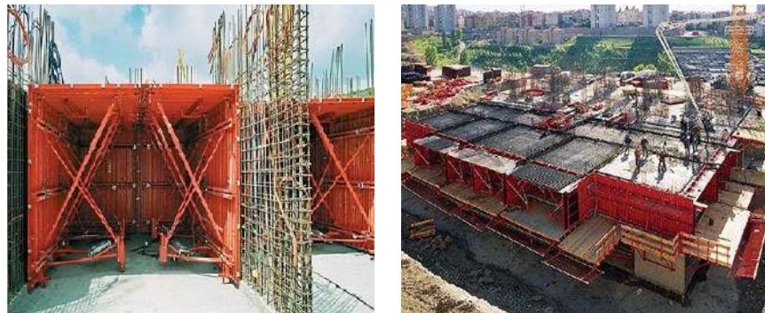
شکل ۹ ساختمان بتن آرمه در دست احداث به روش قالب تونلی
