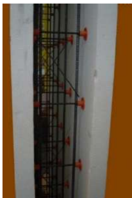
شکل ۵ یک نمونه قالب ماندگار پانلی دارای میلگردگذاری کارخانه‌ای
