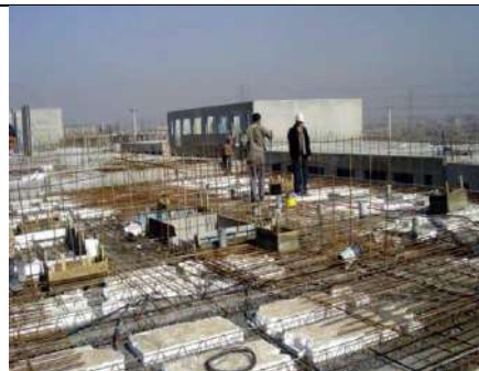
شکل ۳: سقف پیش ساخته قبل از بتن‌ریزی
