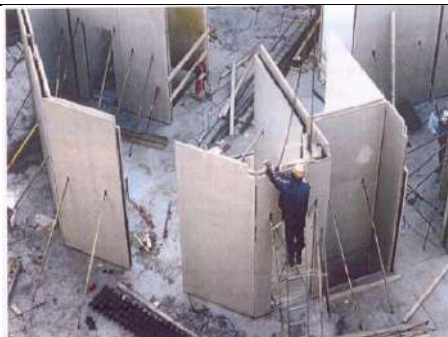
شکل ۴: نصب پانل‌های دیوار در سیستم دیوار دو لایه بتنی
