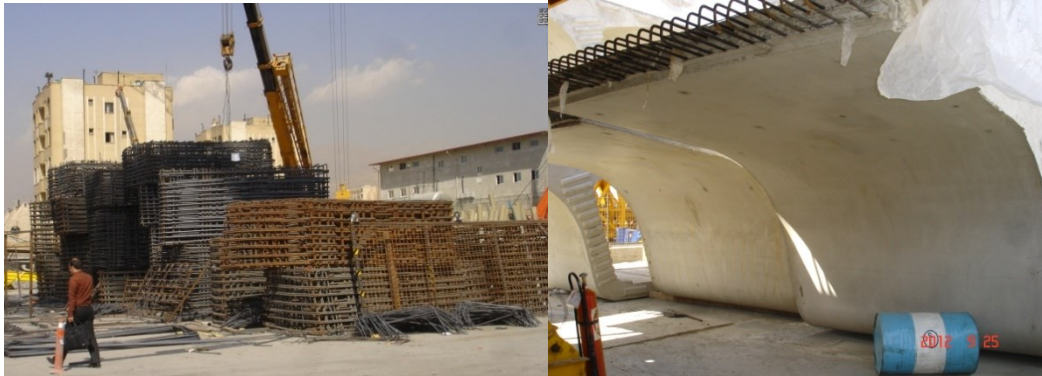
شکل ۱-۴ حجم میلگرد در قطعات پیش‌ساخته سرستون و سطح تمام شده در قطعات عرشه
