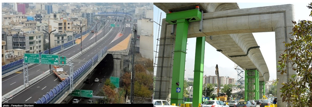
شکل ۳-۱ نمایی از پل صدر (سمت چپ) و پایه‌های دروازه‌ای که با استفاده از بتن خودتراکم ساخته شده‌اند (سمت راست)
