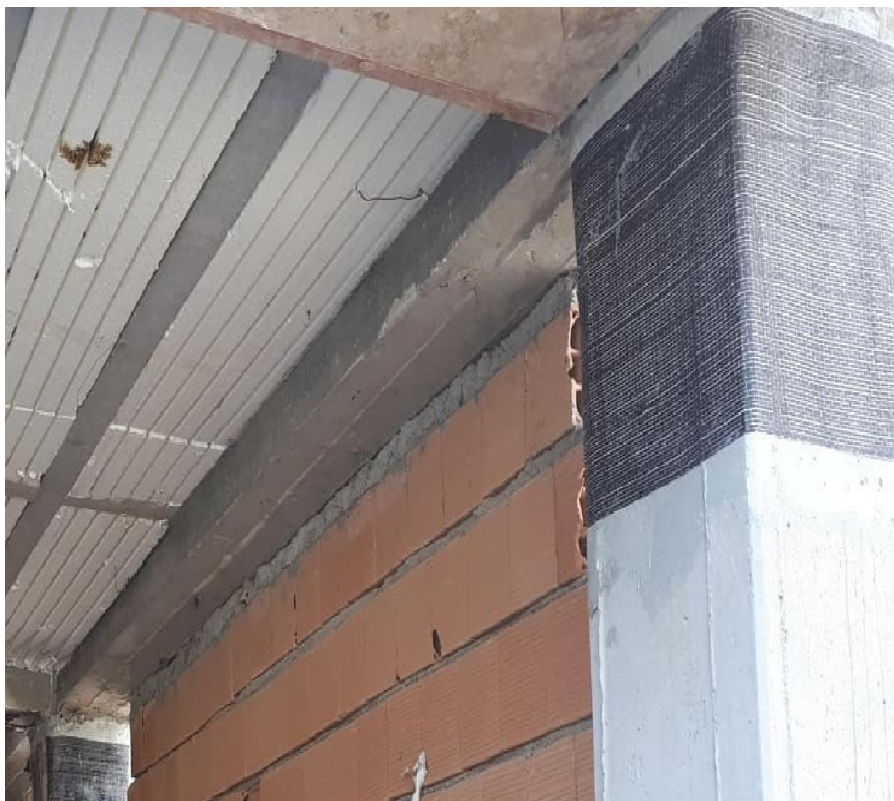
قرار نداشتن تیرچه در مجاورت تیر بتن آرمه
