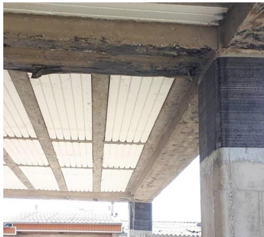
قرارگیری تیرچه در مجاورت تیر بتن آرمه
