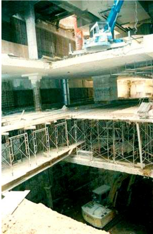
شکل ۳-۷۱ انجام عملیات خاکبرداری به اندازه ارتفاع دو طبقه زیرزمین جهت تسریع در سرعت عملیات خاکبرداری و ایجاد فضای کاری بیشتر برای استقرار ماشین‌آلات بزرگتر
