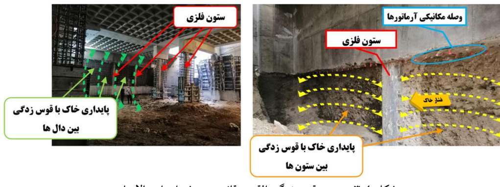
شکل ۴-۳ پدیده‌ی قوس‌زدگی افقی و قائم در روش اجرای بالا-پایین
