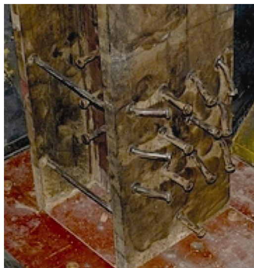
شکل ۳-۳۱ آسیب دیدن گل میخ‌های نصب شده روی ستون پس از عملیات خاک - سیمان چاه و همچنین خاکبرداری.
