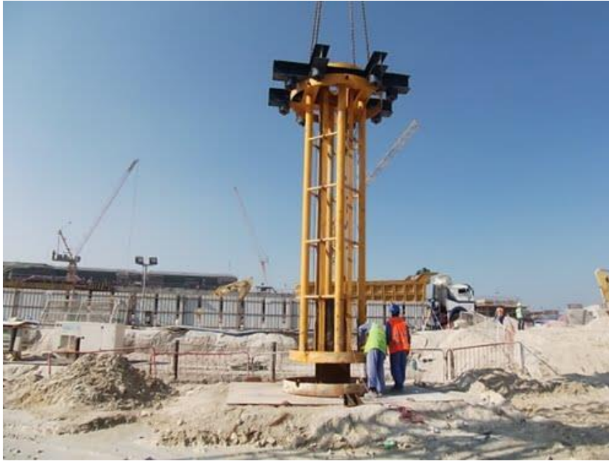
شکل ۳-۱۸ نمونه‌ای از سکوی سرچاهی جهت نصب ستون‌های معلق در روش ساخت بالا-پایین در خارج از کشور.
