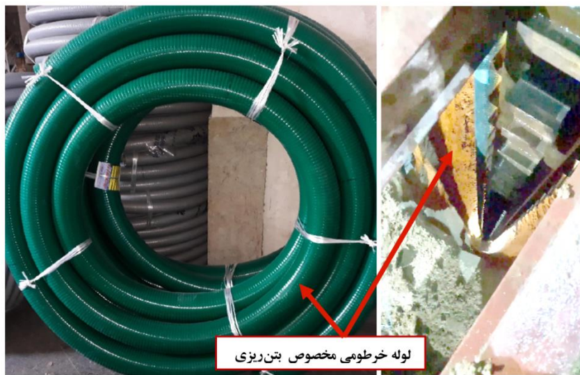
شکل ۳-۱۵ تصویری از یک نوع لوله خرطومی مخصوص بتن‌ریزی به قطر ۵ اینچ که تا انتهای چاه جهت بتن‌ریزی شمع فرو رفته است.
