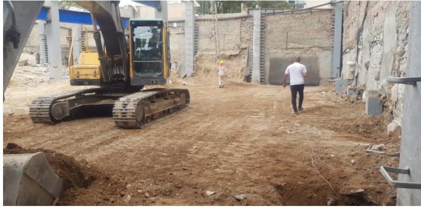
شکل ۳-۹۱ نصب ستون‌های فولادی، پر کردن چاه و سپس تسطیح کف گود به منظور ادامه عملیات اجرایی ساخت به روش بالا-پایین.
