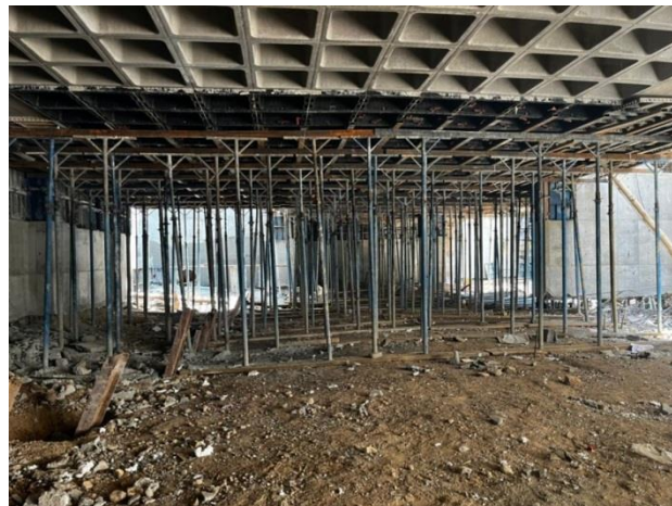
شکل ۳-۱۰۹ قالب‌بندی و اجرای سقف از نوع دال مجوف (وافل) روی جک‌های مستقر شده بر روی سطح خاک
