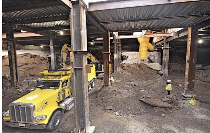
شکل ۳-۱۰۸ استفاده از سقف عرشه فولادی در ساخت به روش بالا-پایین.
