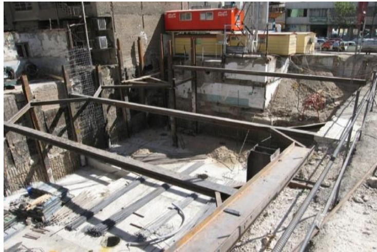
شکل پ ۱-۶ پایدارسازی گود با روش مهارمتقابل
