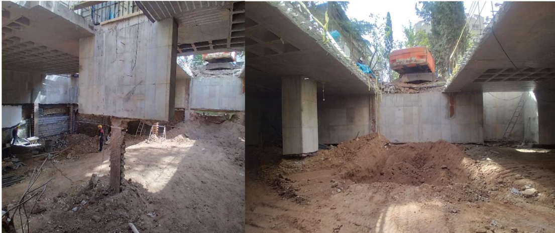
شکل ۱-۱۵ پروژه اندرزگو- الگوی بومی - اسکلت مختلط بتنی فولادی (SRC) - عمق گودبرداری ۱۸ متر.
