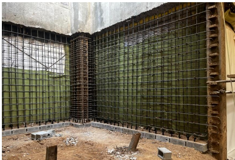
شکل ۳-۱۰۰ شبکه میلگرد دیوار حائل و آماده سازی برای قالب بندی و بتن ریزی.
