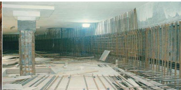
شکل ۳-۹۵-۳-۹۶ اجرای یک دیوار حائل بر روی دیوار حائل مدفون شمعی به صورت مرحله‌ای و از بالا-پایین
