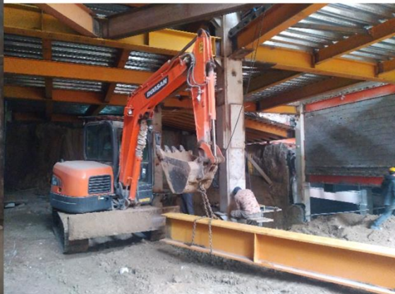
شکل ۱-۱۶ پروژه پاسداران - الگوی بومی - اسکلت فلزی- سقف عرشه فولادی- عمق گودبرداری ۱۸ متر.
