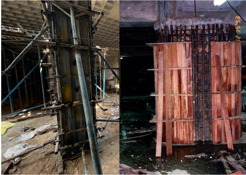
شکل ۳-۳۵ قالب‌بندی چوبی و فلزی ستون مختلط بتنی.
