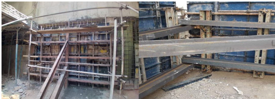
شکل ۳-۱۰۲ نمونه‌ای از نصب پشت‌بند و مهار قالب یکطرفه دیوار حائل به کمک ستون‌های سازه
