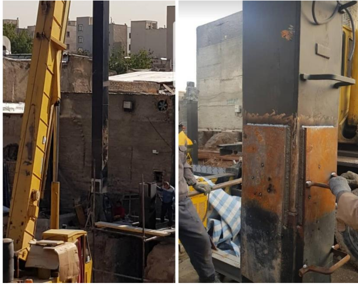
شکل ۳-۲۱ نمونه ای از انجام وصله جوشی ستون فولادی در سر چاه
