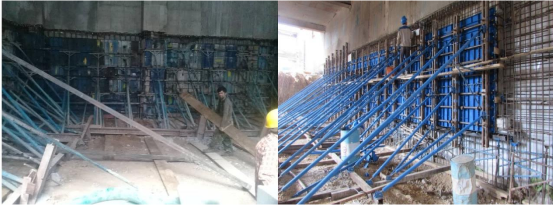
شکل ۳-۱۰۱ نمونه‌ای از نحوه مهار قالب یکطرفه به وسیله جک به تکیه‌گاه‌هایی که در زمین کف گود ایجاد شده است.
