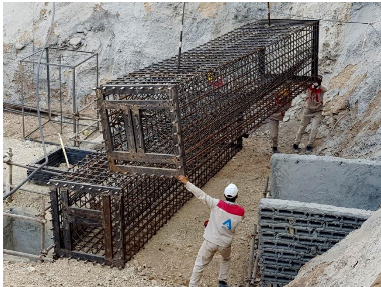
شکل ۳-۸ سبد میلگرد بافته شده به شکل مربع و استفاده از شابلون فولادی جهت ایجاد صلبیت و یکپارچگی سبد و همچنین اتصال میله-مهارهای صفحه‌ستون به سبد میلگرد شمع
