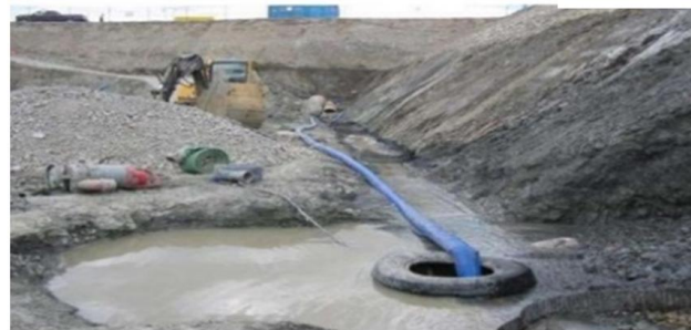
ج - نمونه یک حوضچه پمپاژ کارگاهی
