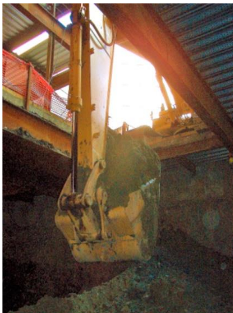
شکل ۳-۷۴ خروج خاک از طریق بازشوی ایجاد شده در سقف به وسیله بیل مکانیکی استاندارد.
