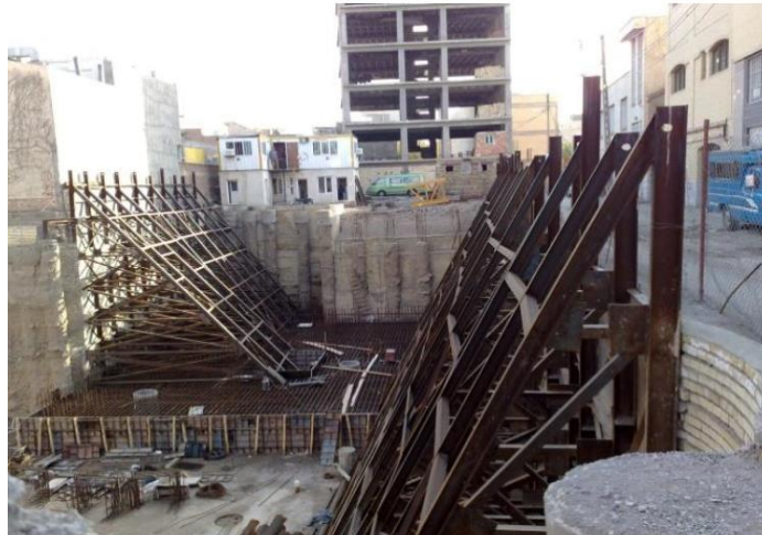
شکل پ ۱-۴ روش سازه نگهبان خریابی
