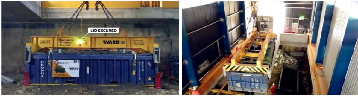
شکل ۳-۸۴ استفاده از جرثقیل دروازه‌ای برای بلند کردن و بیرون کشیدن کانتینر حامل خاک آلوده به مواد نفتی در یک پروژه ساخت به روش بالا-پایین.
