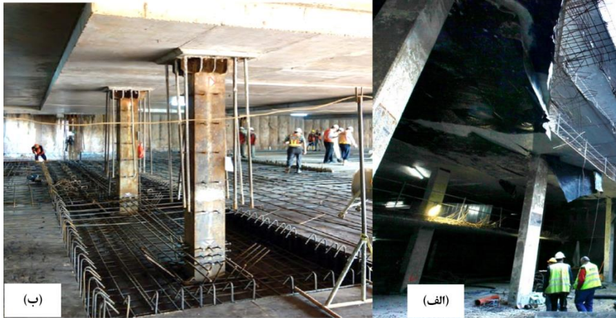
شکل ۳-۱۱۱ اجرای تیر-دال سازه در روش بالا-پایین، (الف) استفاده از تخته چندلایه (پلای وود) روی سطح زمین برای قالب بندی سقف تیر-دال در روش ساخت از بالا-پایین، (ب) سقف بر روی ورق های لاستیکی ریخته شده است
