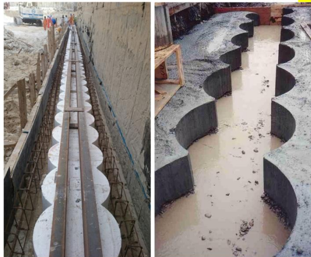
شکل ۳-۴۶ اجرای دیواره هادی بتنی در سر چاه به کمک قالب پلی استایرن در اجرای دیوار شمع مماسی.
