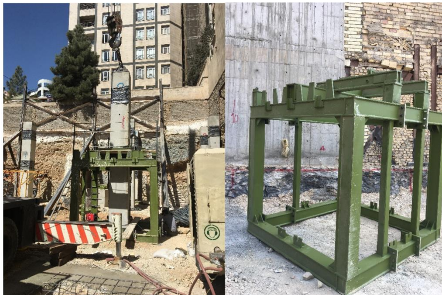
شکل ۱۶-۳ یک نمونه از اجزای نصب ستون به صورت معلق در سرچاه در روش بالا-پایین
