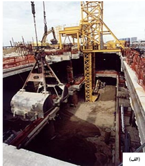
شکل ۳-۷۹ تصاویری از تخلیه خاک به وسیله، (الف) چنگک و (ب) مخزن خود بازشو که از جرثقیل آویزان و جهت انتقال خاک به بیرون از پروژه استفاده می‌شود
