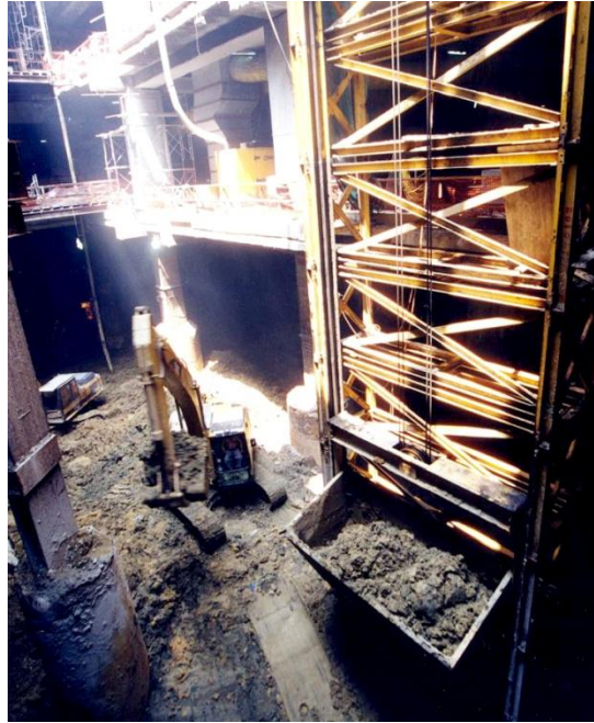
شکل ۳-۸۶ انتقال خاک به وسیله بالابر در اجرای سازه باروش بالا-پایین.
