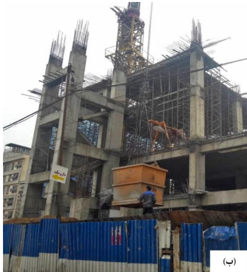
شکل ۳-۷۹ تصاویری از تخلیه خاک به وسیله، (الف) چنگک و (ب) مخزن خود بازشو که از جرثقیل آویزان و جهت انتقال خاک به بیرون از پروژه استفاده می‌شود
