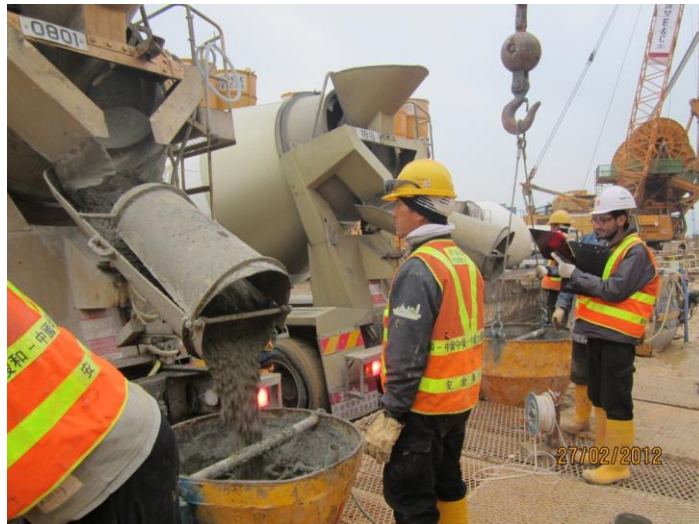
شکل ۳-۶۰ بتن ریزی قطعات دیوار بتنی به وسیله لوله های ترمی.
