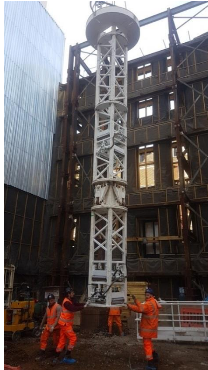
شکل ۳-۱۹ نمونه‌ای از سکوی سرچاهی جهت نصب ستون‌های معلق در روش ساخت بالا-پایین در خارج از کشور که دارای جک‌های هیدرولیکی و سیستم پایش و تراز دقیق و دیجیتال می‌باشد.
