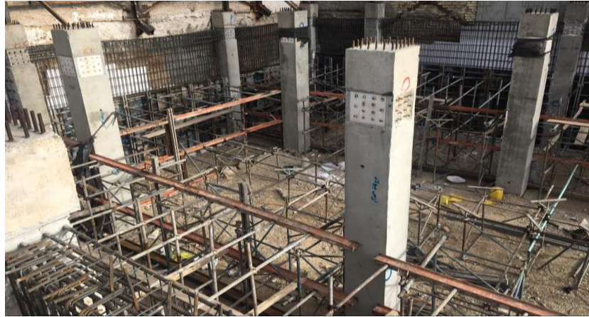
شکل ۳-۱۰۳ مهار قالب یکطرفه دیوار حائل به ستون‌های میانی سازه با شاسی‌کشی فولادی
