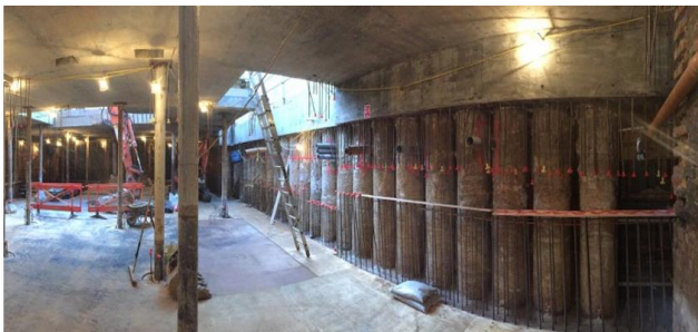
شکل ۳-۹۵-۳-۹۶ اجرای یک دیوار حائل بر روی دیوار حائل مدفون شمعی به صورت مرحله‌ای و از بالا-پایین
