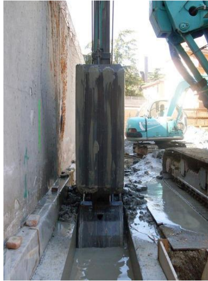
شکل ۳-۵۷ حفاری ترانشه دیوار دیافراگمی، به وسیله چنگک از طریق دیواره‌های سر ترانشه و همزمان با چرخش گل حفاری.
