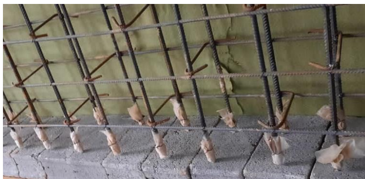
شکل ۳-۹۸ محافظت از وصله مکانیکی (کوپلر) با پوشش پلاستیکی جهت جلوگیری از گرفتگی وصله و خراب شدن رزوه
