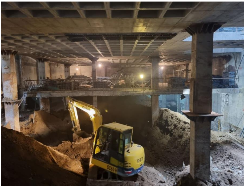
شکل ۳-۶۹ کار کردن یک دستگاه مینی‌بیل در فضای زیرزمین در اجرای سازه به روش بالا-پایین.
