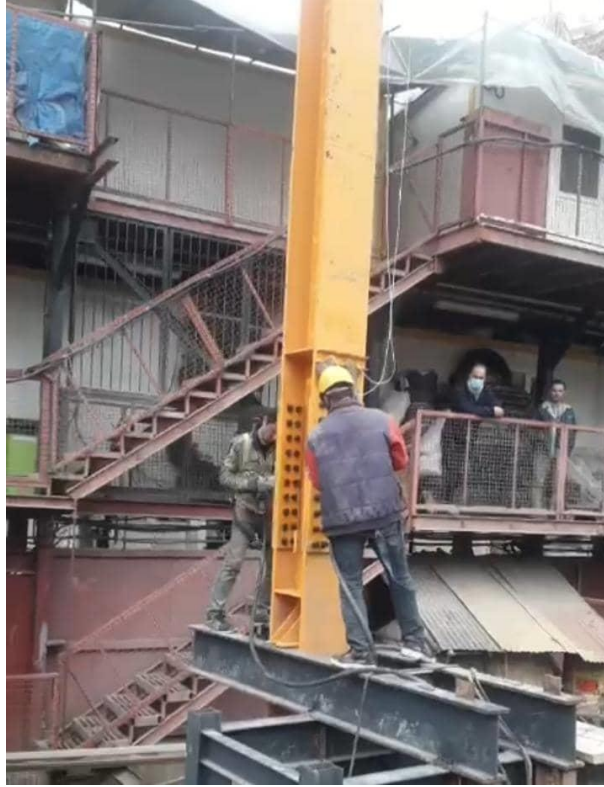
شکل ۲۲-۳ نمونه ای از انجام وصله پیچی ستون فولادی به صورت معلق در سر چاه
