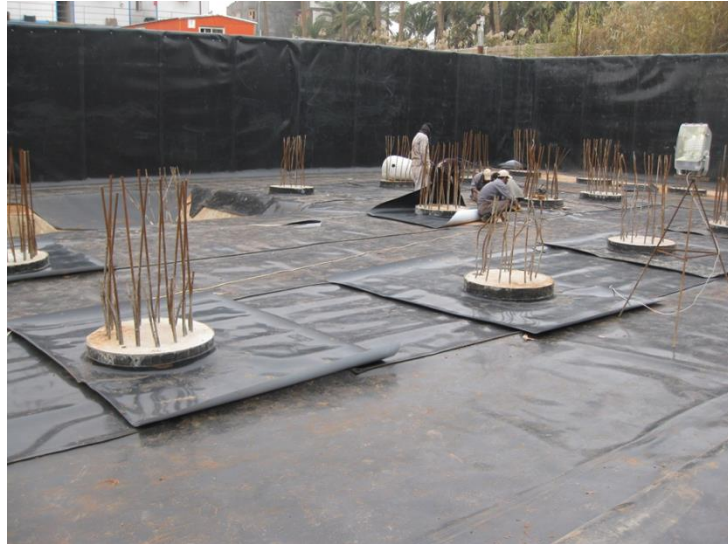
شکل ۳-۱۲۴ نمونه اجرای ژئوممبرین در مجاورت شمعها و قبل از اجرای پی
