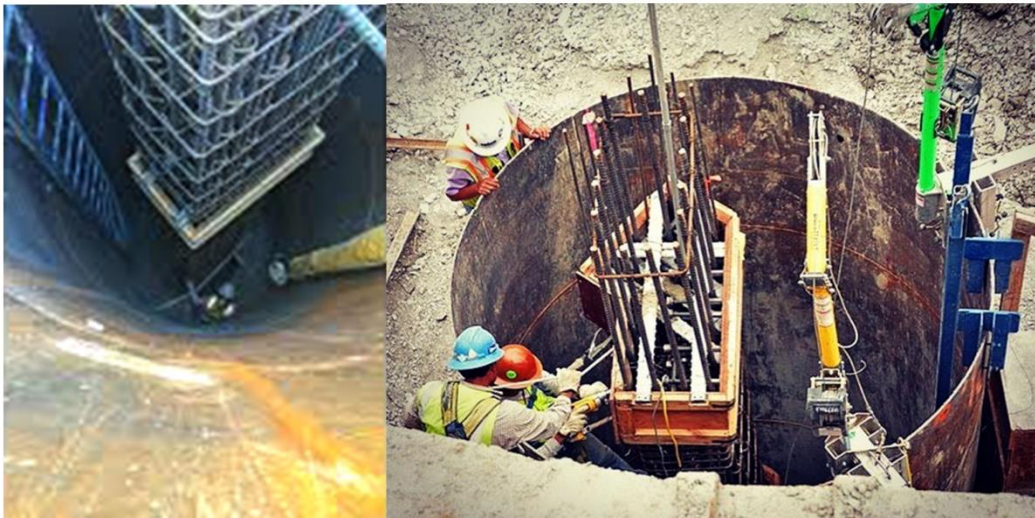
شکل ۳-۳۸ آرماتوربندی و قالب‌بندی ستون بتنی در یک چاه پایدار شده با غلاف فولادی، راه دسترسی ایمن، تهویه و روشنایی برای نیروهای کار تامین شده است
