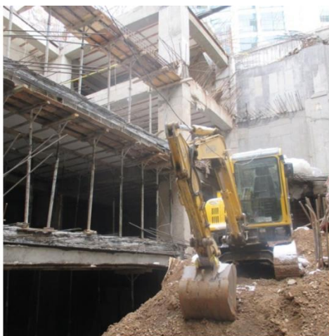
شکل ۱-۱۷ پروژه دیباجی جنوبی - الگوی بومی- اسکلت بتنی با ستون‌های درجاریز- عمق گودبرداری ۱۴ متر
