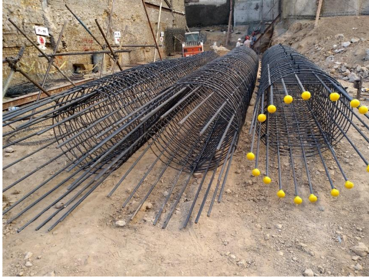
شکل ۳-۷ سبد میلگرد بافته شده به شکل دایره برای نصب ستون‌ها به روش معلق و مهار شده در بخش فوقانی شمع، میلگردهای عرضی شامل خاموت‌های دورپیچ دایره‌ای و همچنین خاموت بسته لوزی می‌باشد. (جزئیات ارائه شده در شکل ۳-۵).
