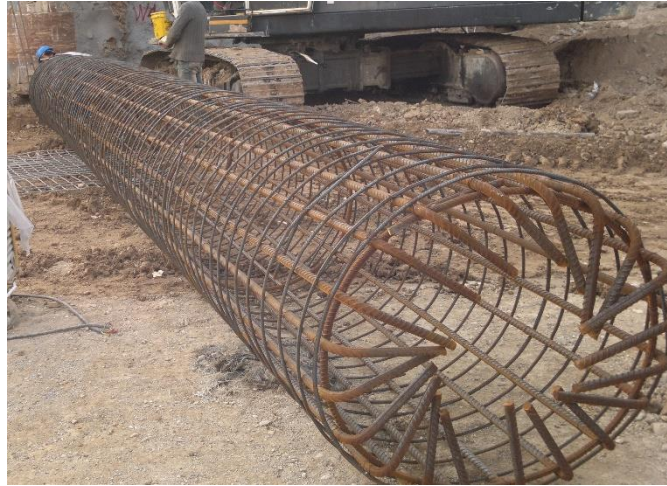
شکل ۳-۹ سبد میلگرد بافته شده به شکل دایره برای نصب ستون‌ها به روش معلق و مهار شده در بخش فوقانی شمع، میلگردهای عرضی به صورت دورپیچ می‌باشد (جزئیات ارائه شده در شکل ۳-۵)
