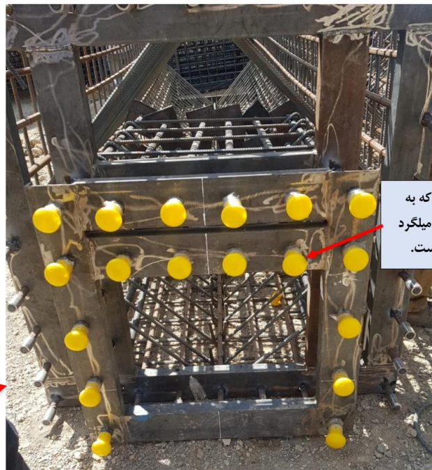
شکل ۳-۱۰ صفحه شابلون میل مهارهای صفحه ستون که به سبد میلگرد شمع متصل شده است.
