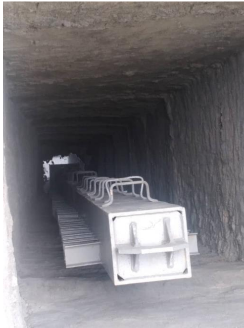
شکل ۳-۲۸ نصب ستون فلزی در سازه فلزی به روش بالا-پایین بر روی پیچ (بولت) های کف ستون و روی شمع در چاه.
