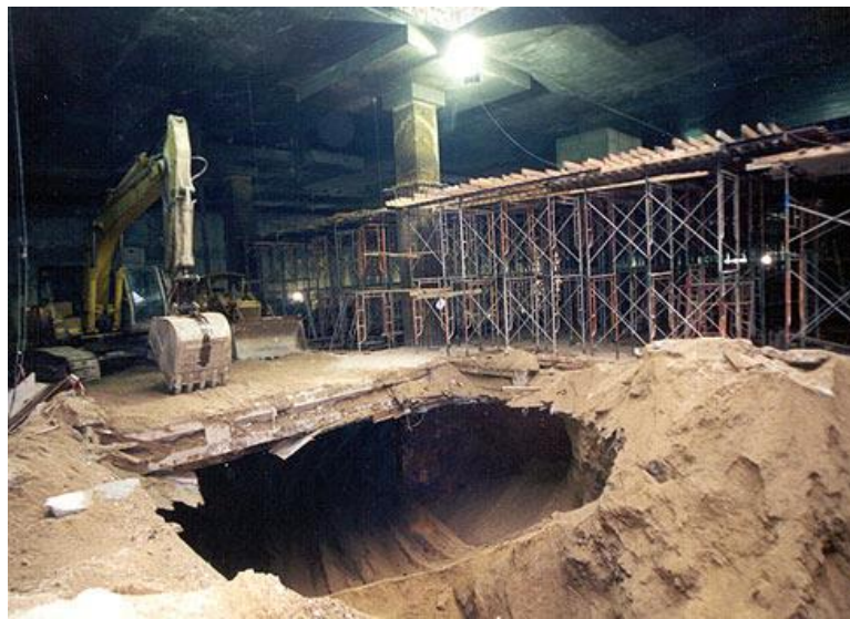
شکل ۶-۱ انجام خاکبرداری زیر دال اجرا شده در حالیکه ستون‌ها و سقف طبقات فوقانی اجرا شده است.
