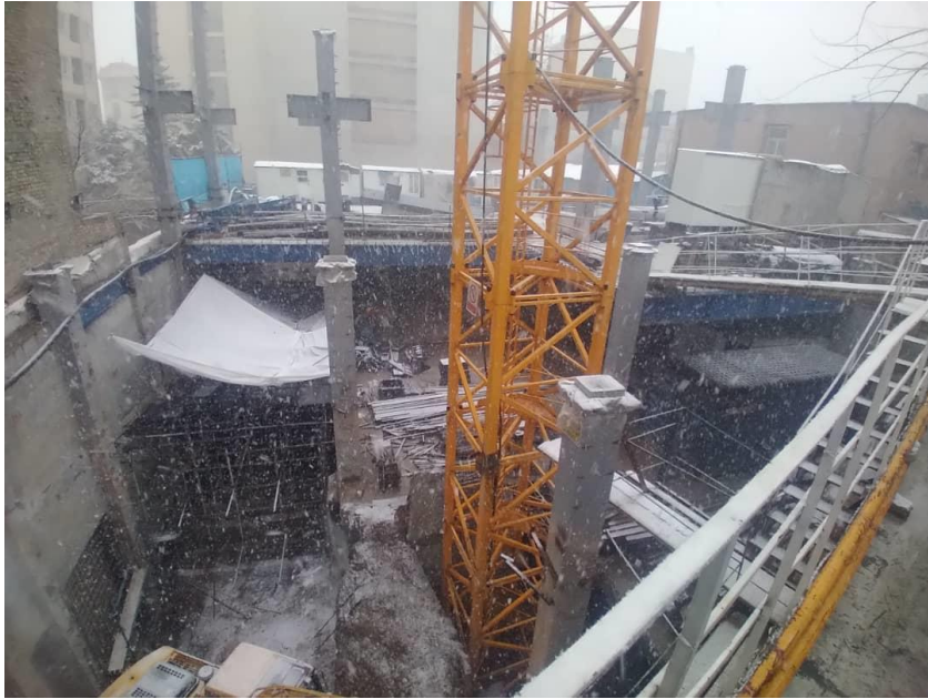
شکل ۱۸-۱ پروژه شهید کلاهدوز - الگوی یومی - اسکلت فلزی - سقف طبقات زیرزمین دال وافل، عمق گودبرداری ۲۲ متر
