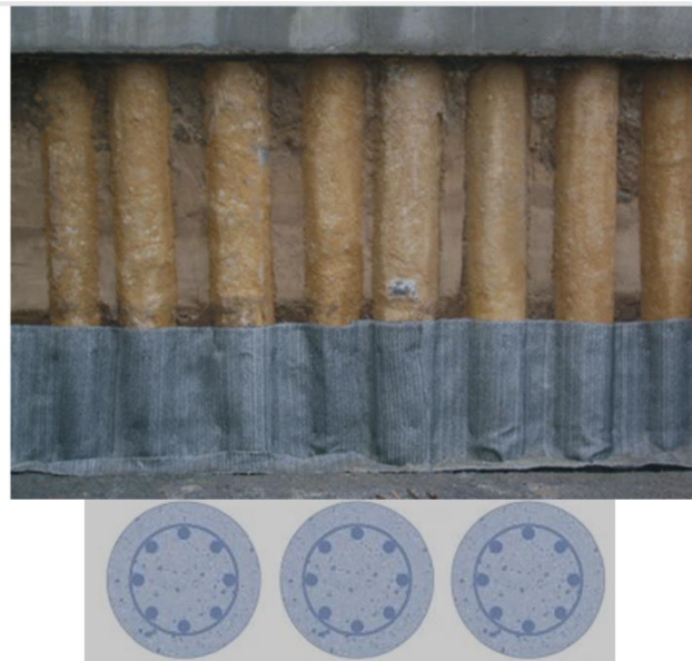
شکل ۳-۵۱ نما و مقطع دیوار شمع‌های منفصل که بین هر دو شمع فاصله‌ای وجود دارد و جبهه خاک بین دو شمع باید بتواند پایدار باقی بماند
