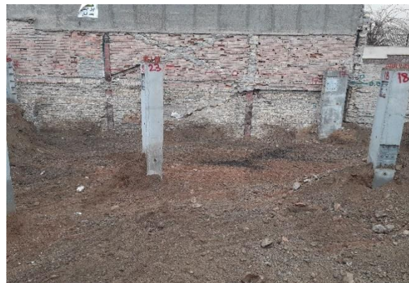
شکل ۳-۹۲ نصب ستون‌های پیش‌ساخته بتنی در سایت پس از پر کردن چاه و آماده‌سازی سایت جهت اجرای سقف و دیوار حائل اولین زیرزمین.
