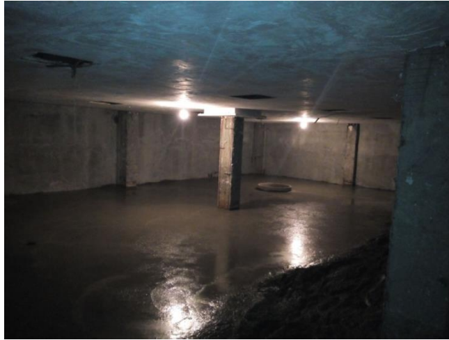
شکل ۳-۱۲۶ نمونه اجرای بتن آب‌بند بر روی فونداسیون
