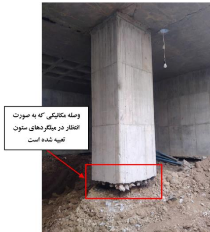
شکل ۳-۳۶ مقطع نهایی اجرا شده ستون مختلط بتنی
