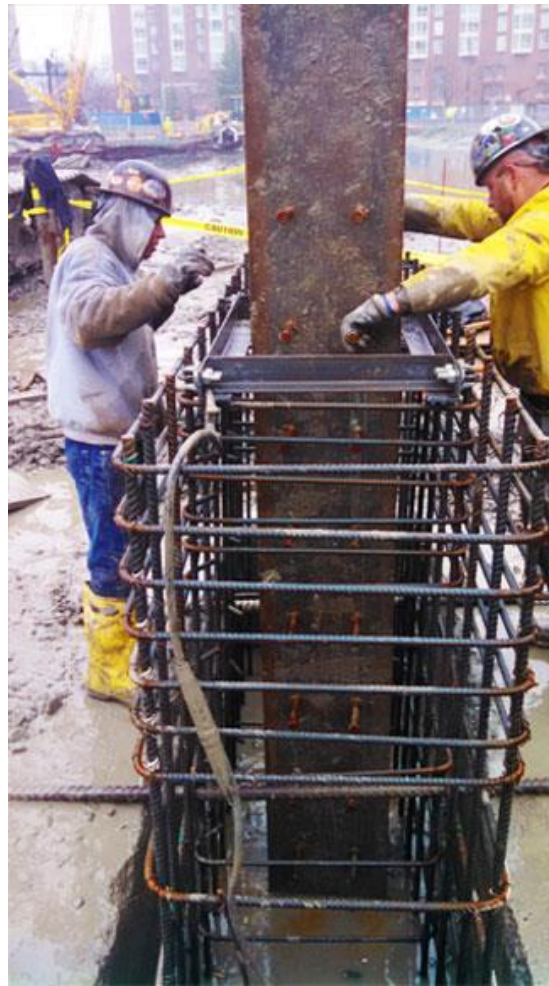
شکل ۳-۴ نصب شبکه میلگرد دیوار دیافراگمی به کمک دیواره هادی و معلق نگه داشتن قطعه تحتانی در سر ترانشه جهت وصله به قطعه فوقانی
