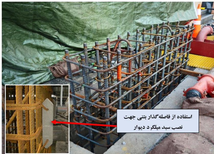
شکل ۳-۴۳ فاصله‌گذار بتنی در احداث دیوار بتنی
