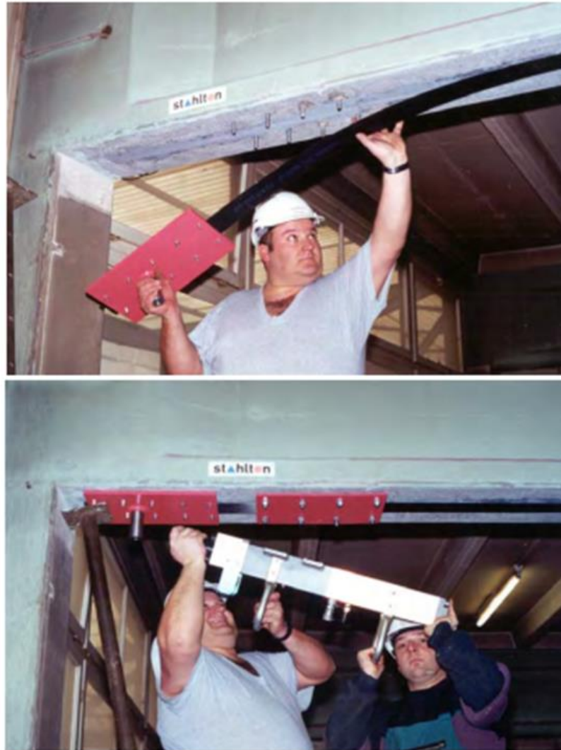
شکل ۲-۴-۱۷- روش پیش تنیدگی در صفحه FRP
