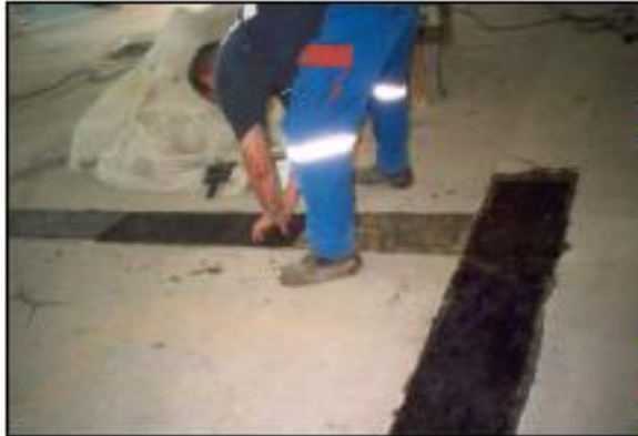
شکل ۲-۳-۱۰- تقویت دال با استفاده از نوارهای FRP در نواحی لنگر منفی
