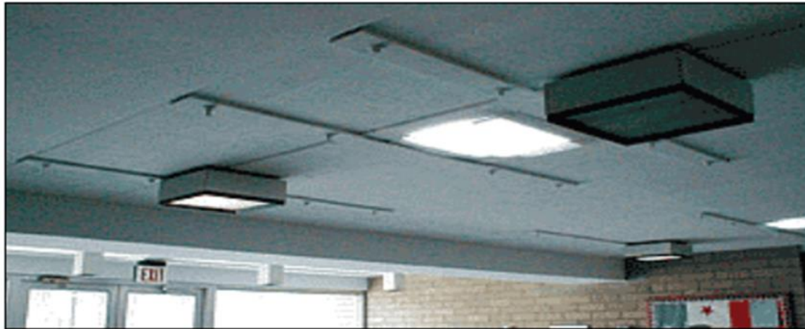
شکل ۲-۳-۷- تقویت دالها با استفاده از ورقهای فولادی
