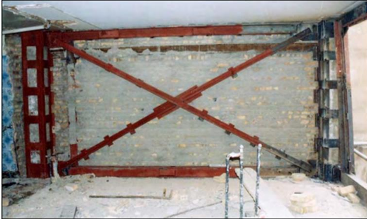
شکل ۴-۵- بهسازی قاب های موجود بوسیله مهاربندهای همگرا
