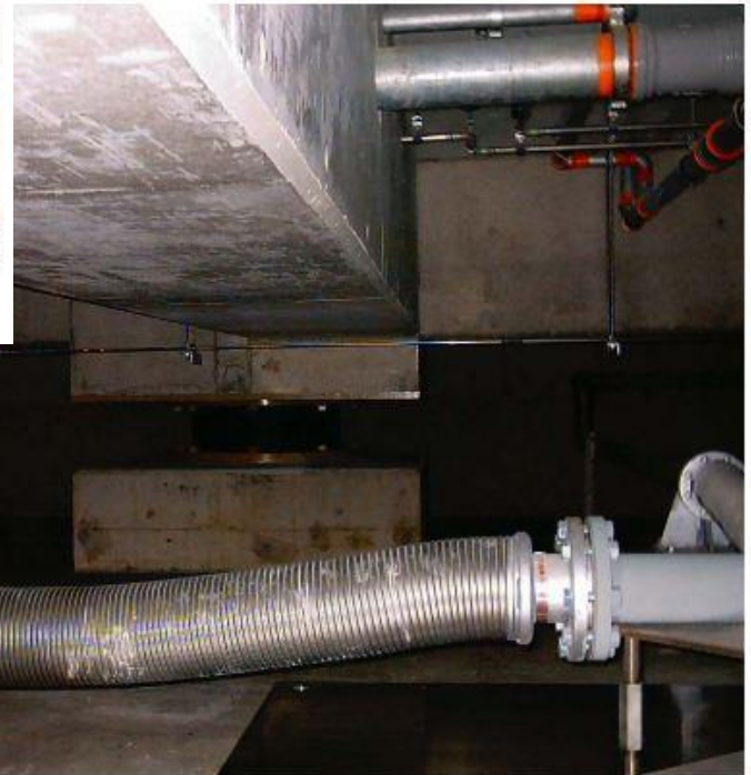
تصویر ۵-۳-الف- استفاده از اتصالات انعطاف‌پذیر در محل عبور لوله‌های تاسیسات از طبقه‌ی جداسازی
