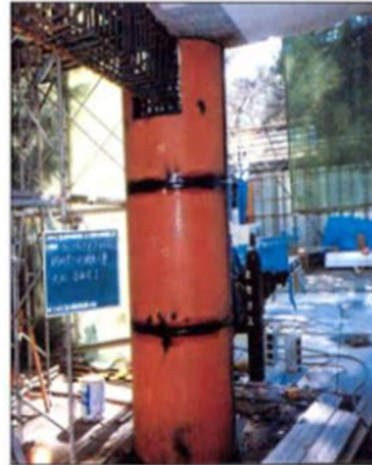
شکل ۲-۵-۱۴- استفاده از روکش فولادی مدور در بهسازی ستون های مستطیلی
