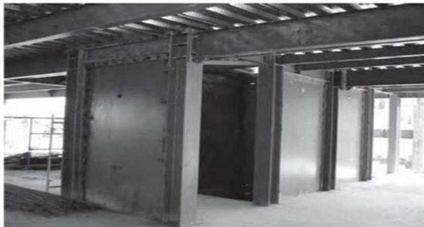
شکل ۴-۵۰- دیوار برشی فلزی
