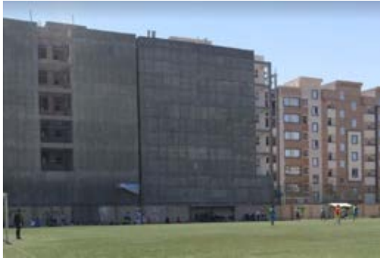
تصویر ۶۹- بی‌توجهی به نمای فرعی ساختمان‌های مجاور زمین ورزشی، محله شریعتی شمالی
