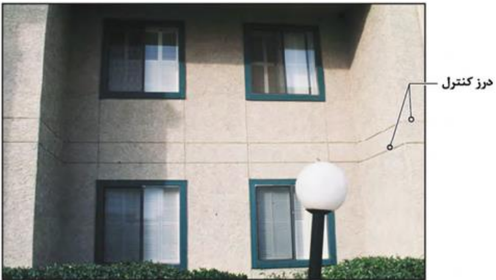
شکل ۶-۸- نمونه درزهای کنترل بر روی نمای سیمانی
